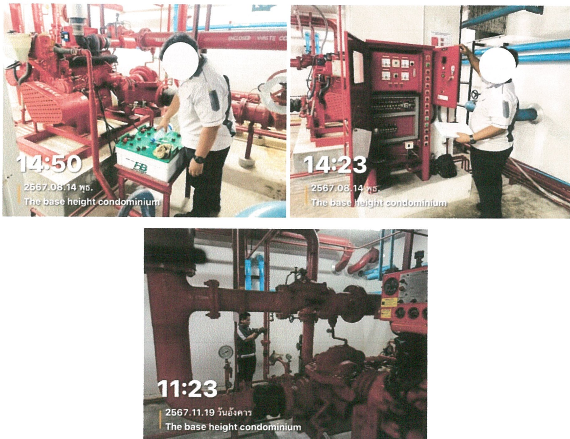
รูปภาพที่ 2.54 การตรวจสอบระบบป้องกันและเตือนอัคคีภัย
