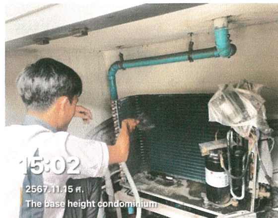
รูปภาพที่ 2.29 การล้างเครื่องปรับอากาศ
